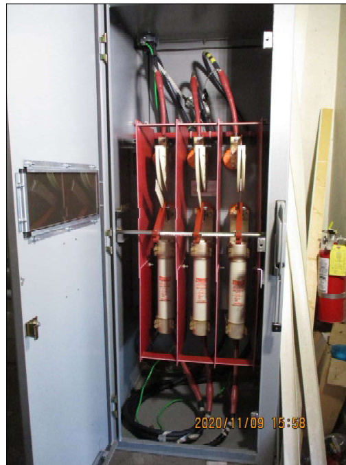
NEW 100A LUG TAP ASSEMBLY SHOWN HIGHLIGHTED (LUGS BY OTHERS)
